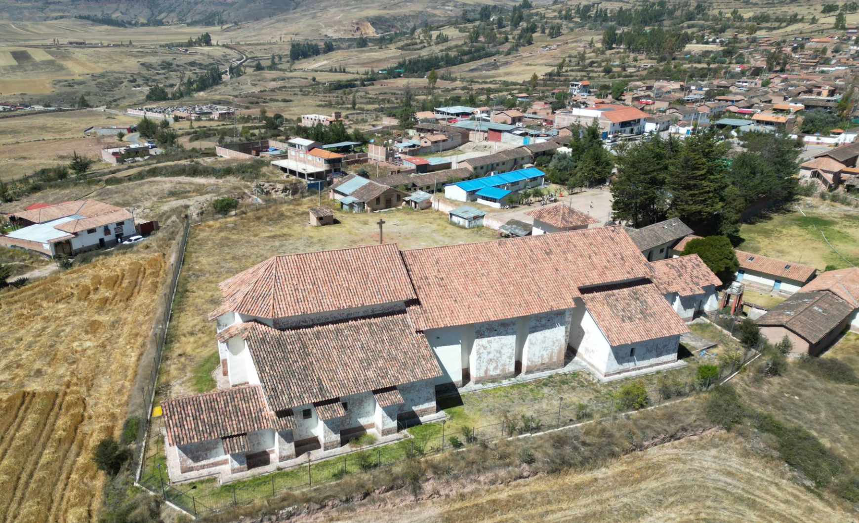
Vista nor-este del templo San Francisco de Asís de Maras, se aprecia en el extremo derecho el bautisterio y la sacristía, adosadas al muro del evangelio.
