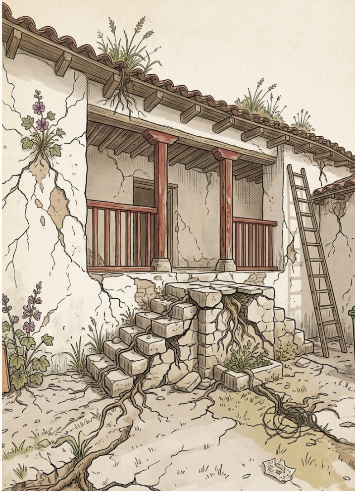
La vegetación es capaz de romper incluso los pisos de cemento.
