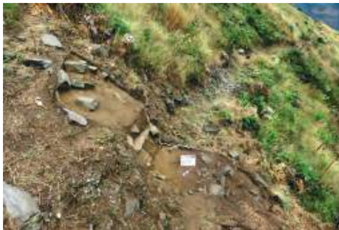
Foto 15. Camino tipo plataforma con corte de talud, sección Inca Cárcel – Lucmayoq.
