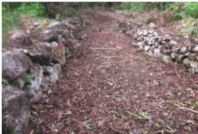
Foto 8. Camino tipo encerrado por muros laterales sector Umasbamba.
