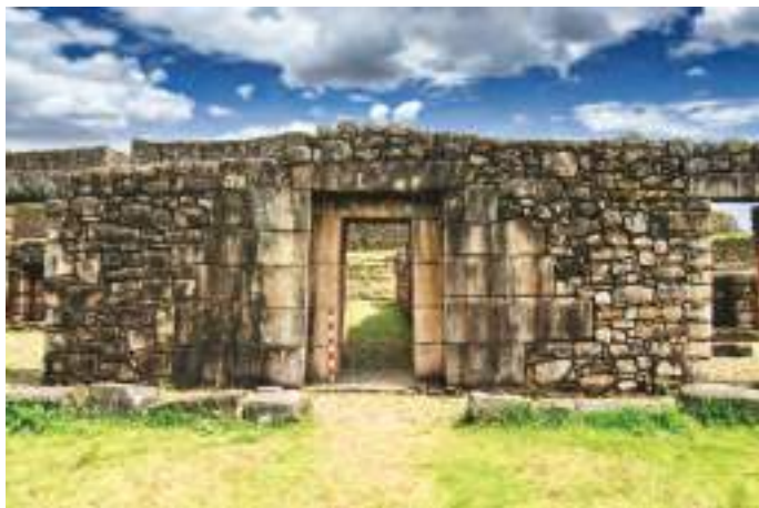
Foto 1. Vista del S.A. de Vitkus (Rosaspata).
