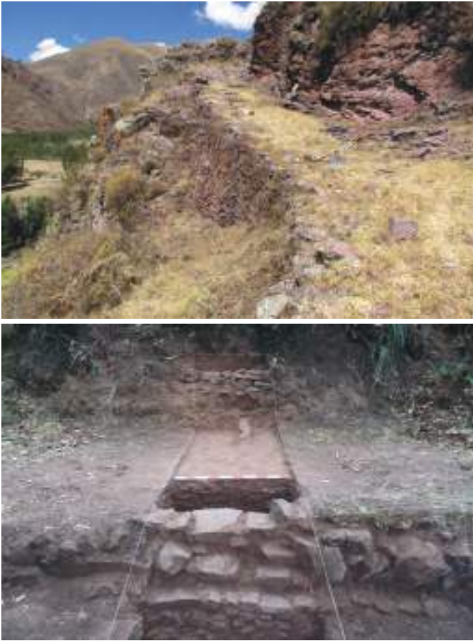
Foto 10. Arriba: segmento de camino en plataforma en corte de talud. Abajo: las excavaciones demostraron segmento de camino con doble muro de sostenimiento.
