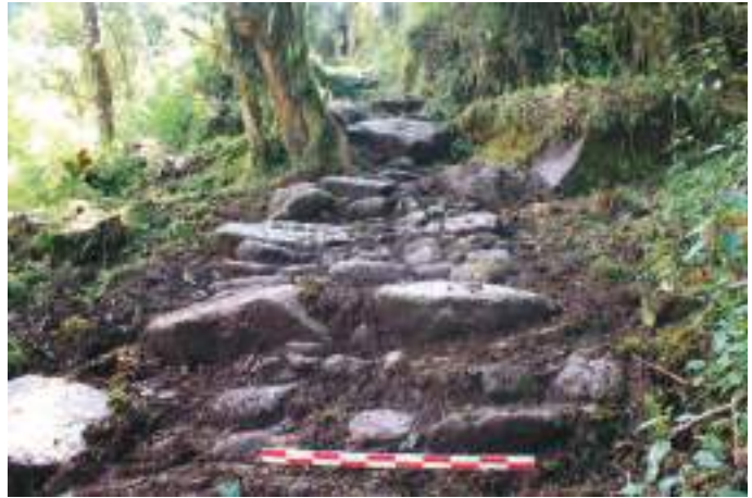
Foto 4. Camino de tipo escalinata con empedrado en regular estado de conservación.
