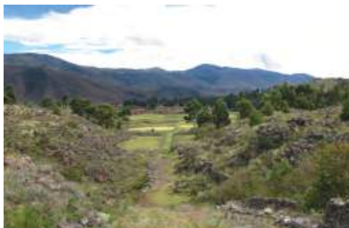
Foto 15. Camino en plataforma con muros de sostenimiento de terraplén, que se dirige al sitio de Raqchi.
