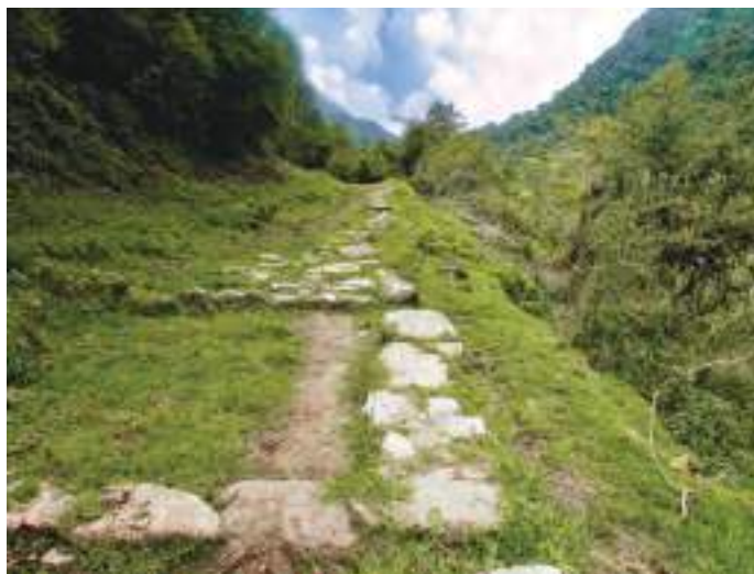
Foto 33. Plataforma corte talud con calzada empedrada en el camino Vitkus-Espititu Pampa, sector de Ututo. Fuente IRA-PQÑ-2015.
