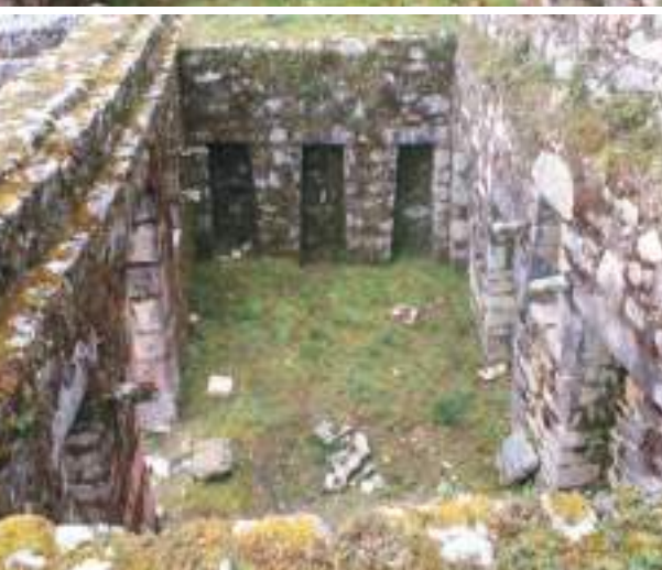
Fotos 24 y 25. Vista general del primer nivel lado oeste y detalle de hornacinas interiores.
