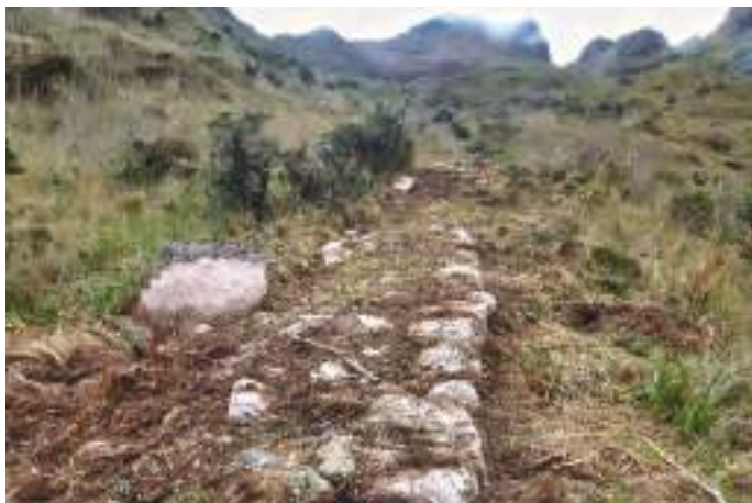
Foto 6. Camino con calzada empedrada, registrado en el sector de Wallaqsayri, en mal estado de conservación.
