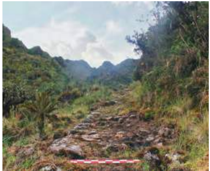
Foto 5. Camino de plataforma con escalinatas y muro de sostenimiento de terraplén, conserva regularmente sus características arquitectónicas.
