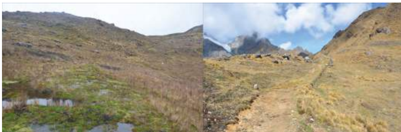
Foto 7. Detalle de camino sobre cobertura vegetal y plataforma con muro de sostenimiento en el sector de Suero Cocha-Mojón (Distrito de Santa Teresa).
