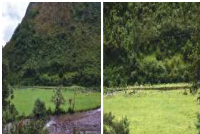
Fotos 2 y 3. Encauzamiento del río Vilcabamba.
