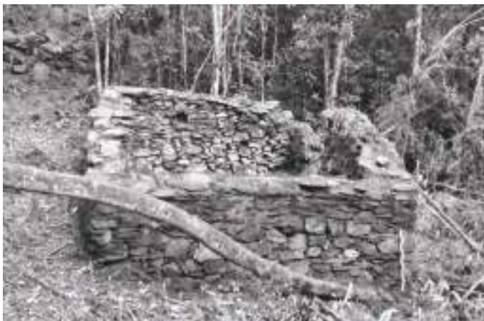
Fotos 4 y 5. Recintos de la parte superior sur del sector I Pasto Grande
