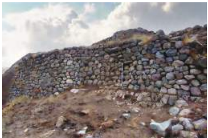
Foto 4. Muro construido en plataforma artificial.
