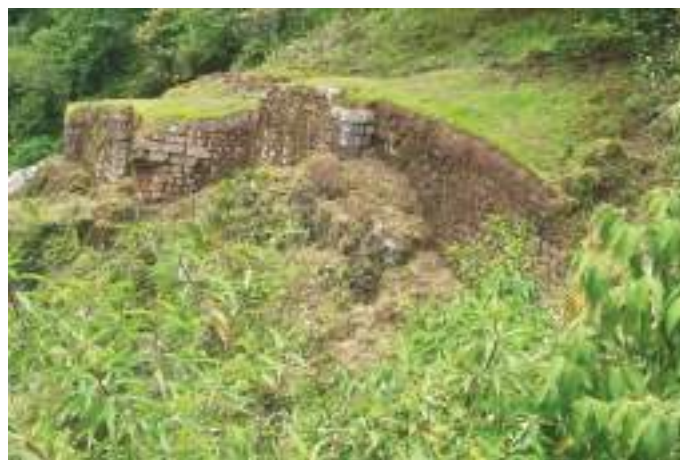
Estructura con tipo de aparejo rústico de piedras semicanteadas.
