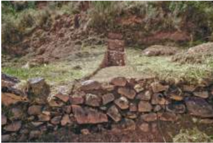
Foto 12. Lado izquierdo. Segmento de camino en plataforma en corte de talud con muros de sostenimiento de terraplén y talud.
