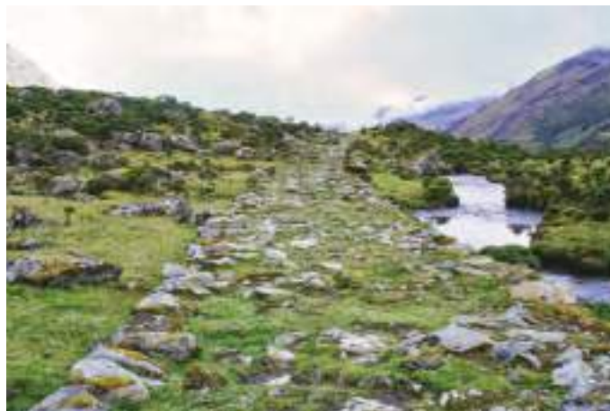
Foto 3. Vista de un segmento de calzada elevada.
